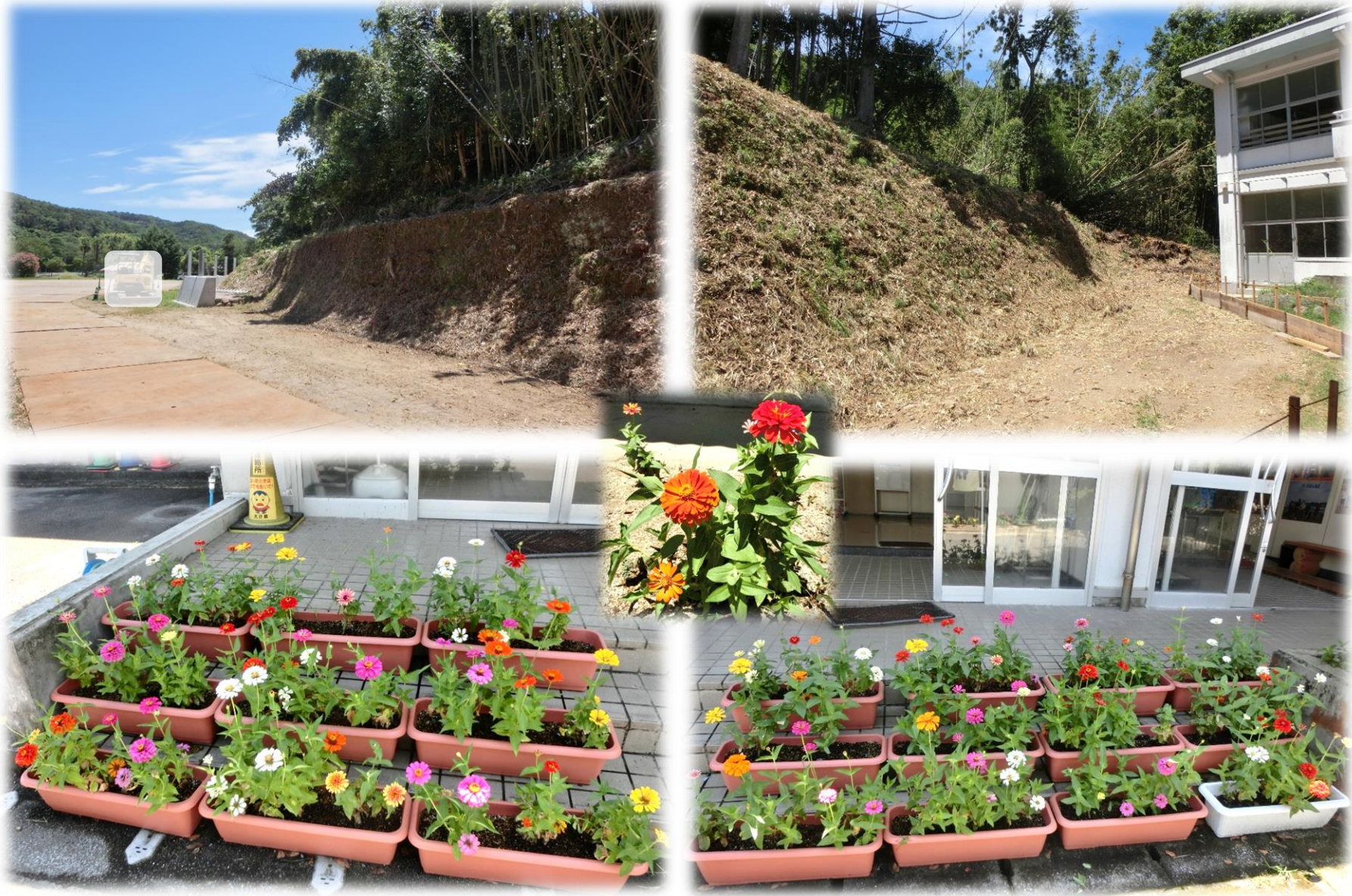
上の写真2枚：学校裏手の「急傾斜災害防止緊急対策事業」の工事の様子です。最後の区画の工事が始まって、竹が生え放題だった斜面が綺麗になっています。 下の写真：「人権の花運動」で植えた花の様子です。暑さで元気のない花もありますが、多くの花は次々と新しい花を咲かせています。
