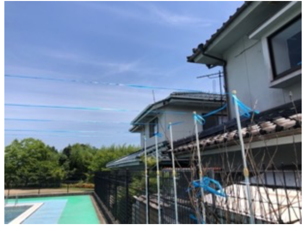
スズランテープと幟の支柱で作ったプール上空のコースロープ 結束バンドでフェンスに止めています
