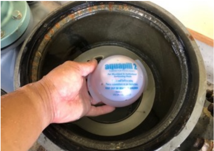
水を透明にするアクアピル（薬品） 水をより透明にすることは子どもたちの水に対する恐怖心の軽減に 濾過器のヘアーキャッチャーに入れて使います
