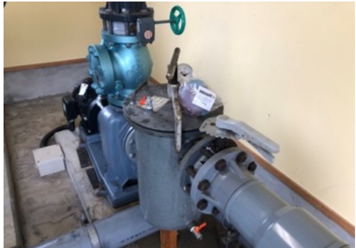
水を透明にするアクアピル（薬品） 水をより透明にすることは子どもたちの水に対する恐怖心の軽減に 濾過器のヘアーキャッチャーに入れて使います
