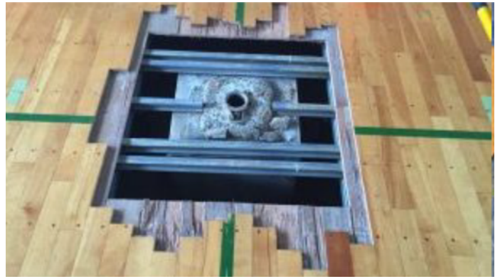
支柱の床下部分はこんな感じで一切弾力なし コンクリートの塊です
