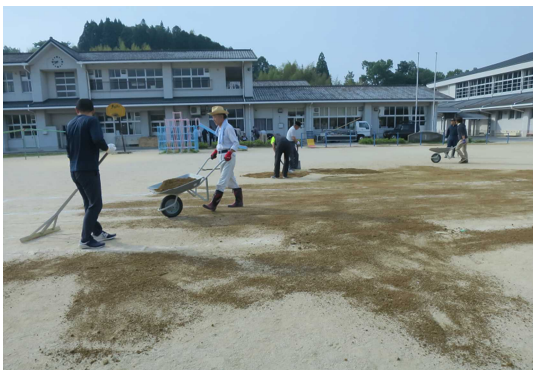
▲校庭への真砂土入れ、整地
